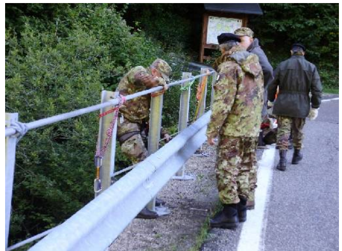
Fasi finali di sistemazione delle attrezzature lungo il ponte
