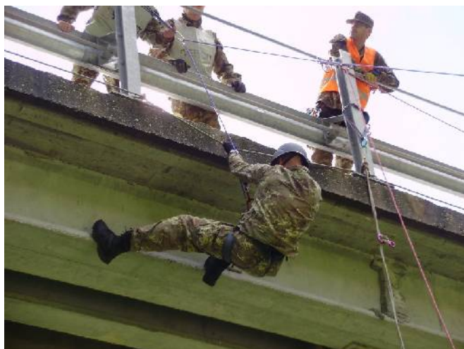
Traverso lungo la trave d'impalcato del ponte
